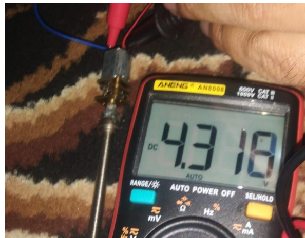
Gambar 8 Pengukuran Tegangan Motor DC
