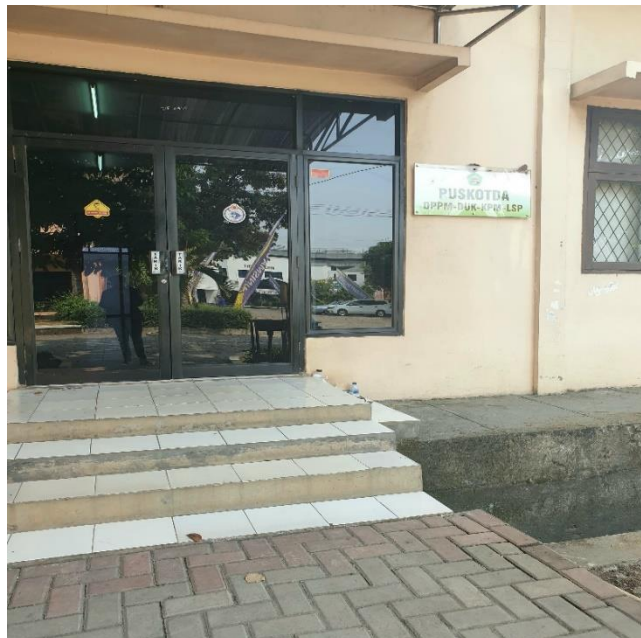
Gambar 4. 3 Gedung LPPM UNISMA
