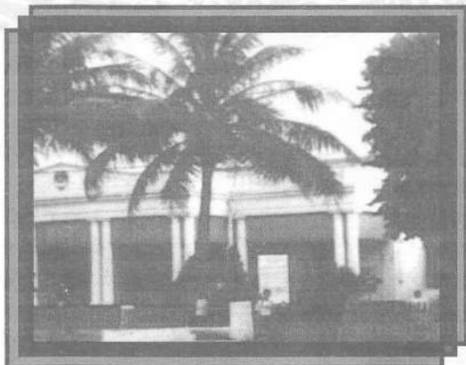
Kantor Bupati Bekasi pertama di Jatinegara (depan stasiun Jatinegara). Kantor tersebut sebelumnya digunakan sebagai kantor Regentschap Meester Cornelis dan kantor Jatinegara Ken. (Saat ini gedung tersebut tidak mendapatkan perawatan yang baik)
