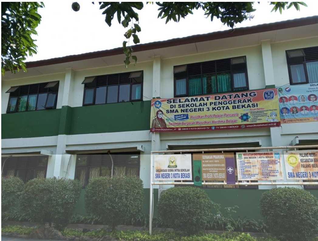
Gedung Sekolah SMA Negeri 3 Kota Bekasi
